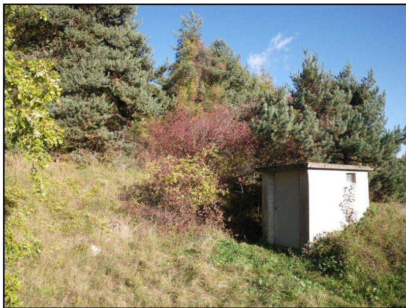
Environnement immédiat du captage des Fonts.
